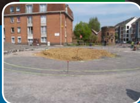
Giratoire de la RD 952 Fin des travaux prévue en juin - p. 11
